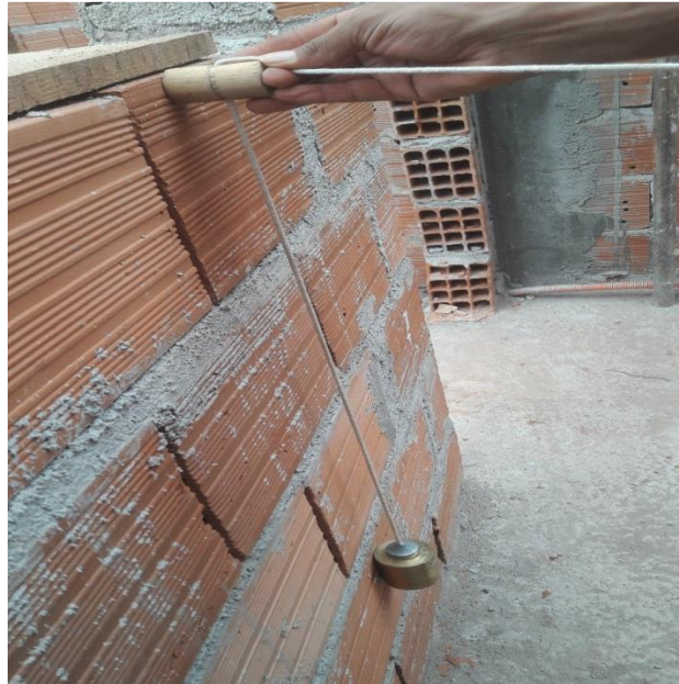
Figura 02: Verificação do prumo de uma parede usando fio de prumo
