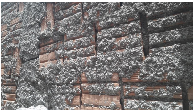
Figura 03: Aplicação de chapisco em uma parede
