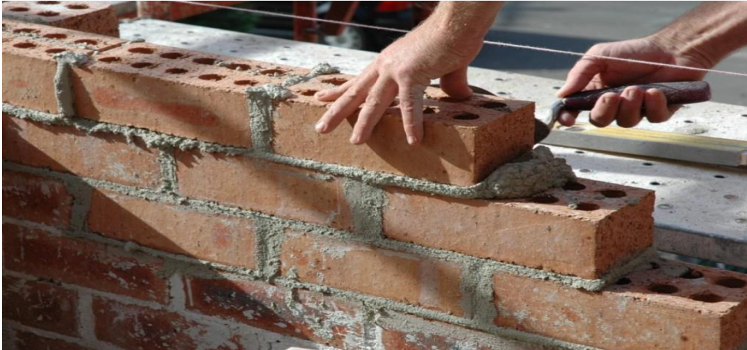
Figura 01: Assentamento de tijolos
