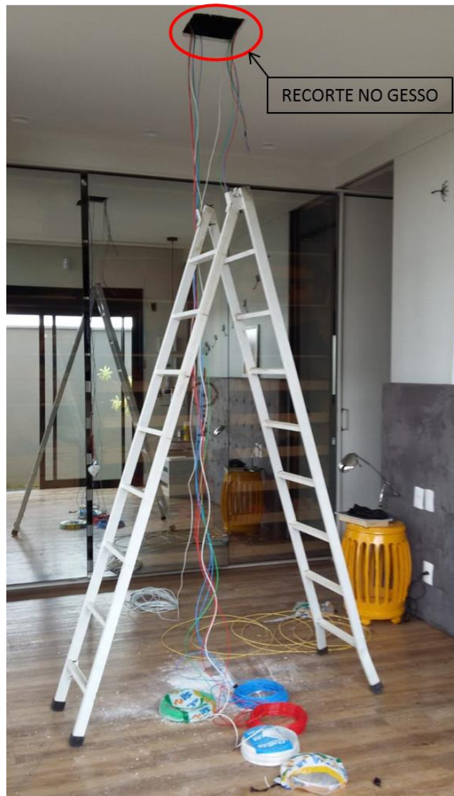
Figura 18 – Instalação do cabeamento
