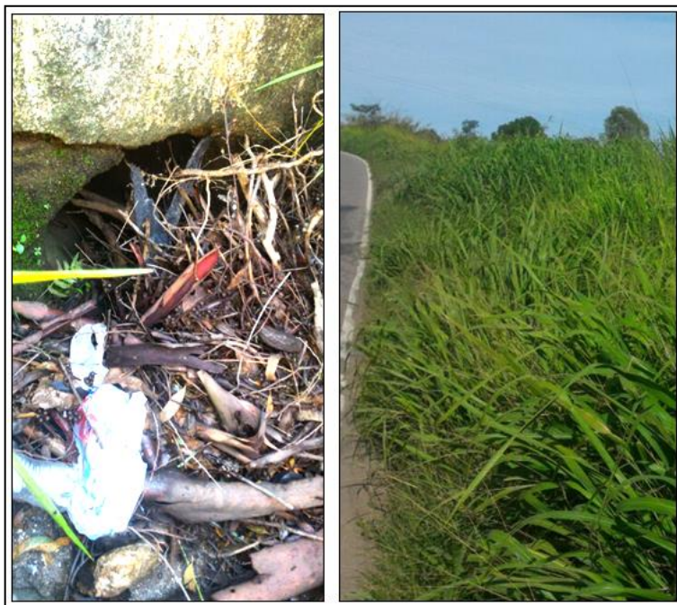
Figura 07 - BSTC \varnothing=0,40\text{m} (est. 393+9,22 PD). Dispositivo completamente aterrado.
