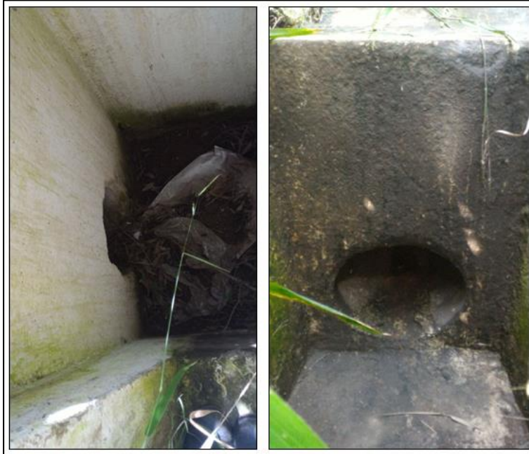
Figura 06 - BSTC \varnothing=0,40\text{m} (est. 366+0,00 PD) com caixa à montante e ala à jusante desobstruída.
