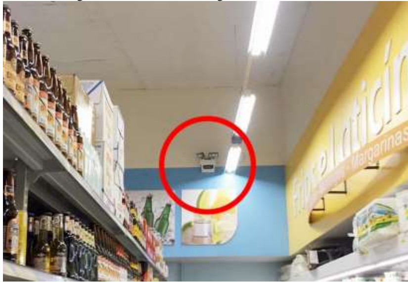
Figura 5. Luminária de emergência na área de vendas
