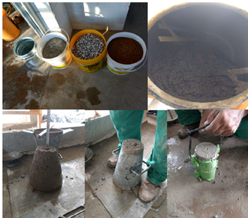
Figura 20-Procedimento da execução de concreto
