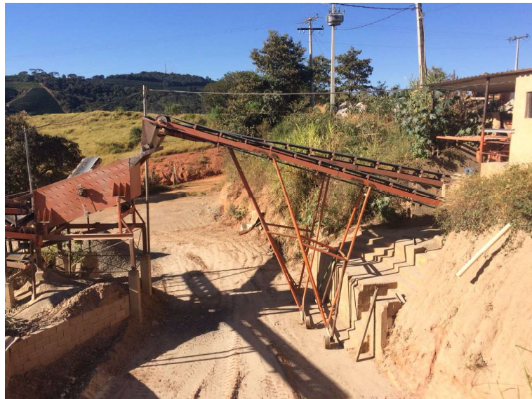
Figura 9- Esteiras que interligam na peneira vibratória
