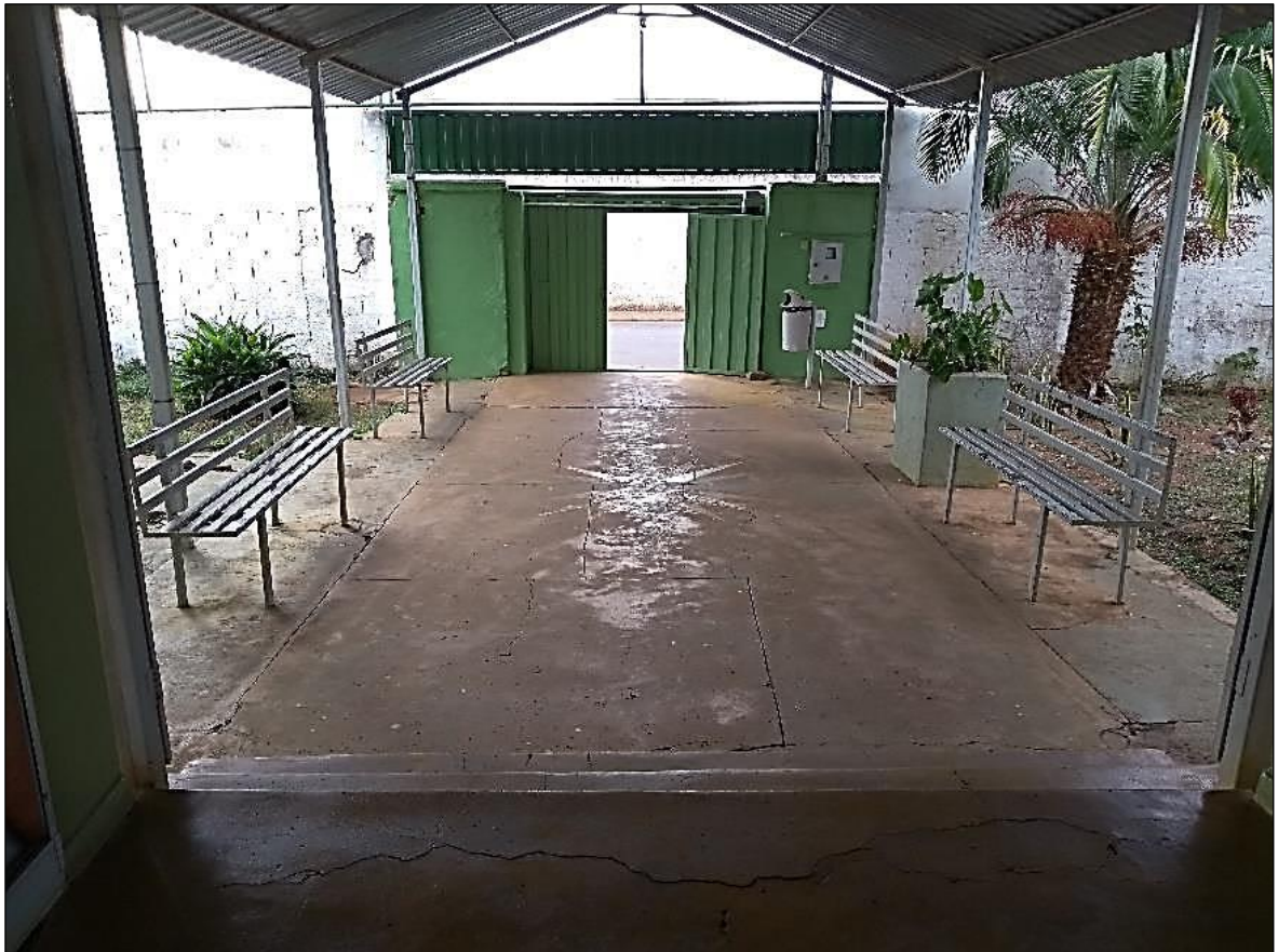
Figura 2: Acesso e descarga saída de emergência 01.
