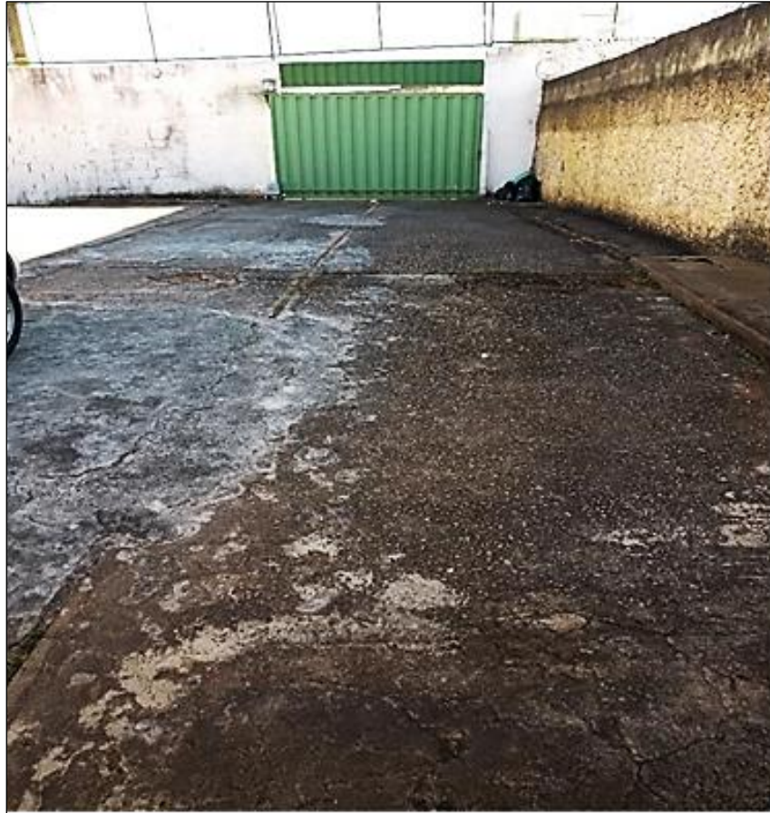
Figura 3: Acesso e descarga saída de emergência 02.
