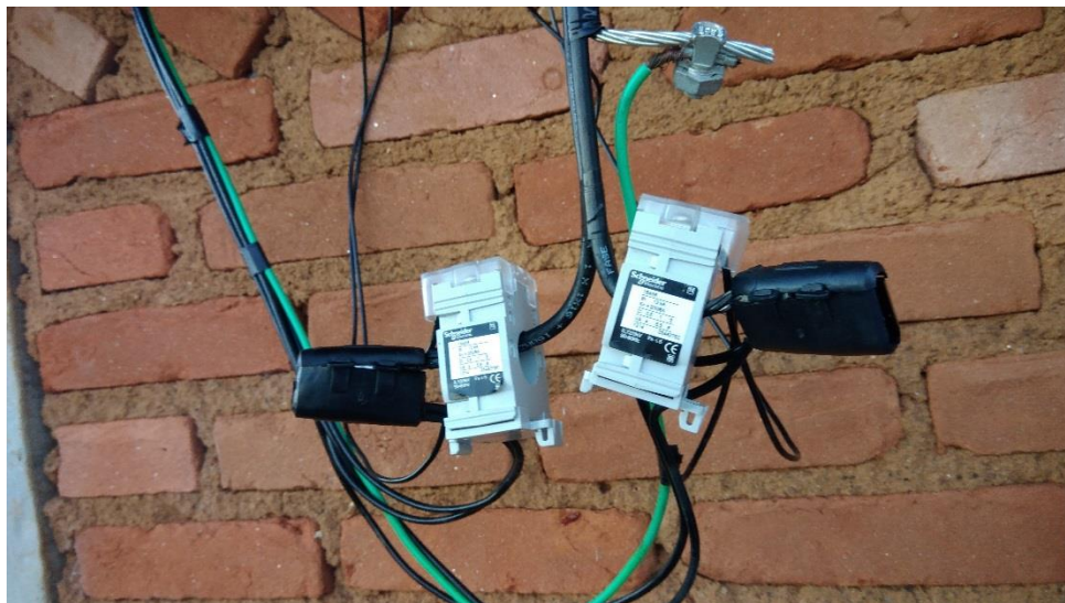
Figura 29 - Ponto de conexão dos sistemas de medição.
