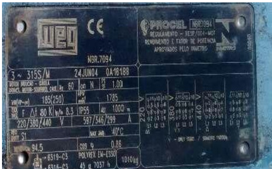
Figura14: Dados de placa do motor.
