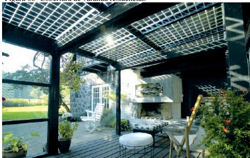
Figura 06- Cobertura de varanda residencial.
