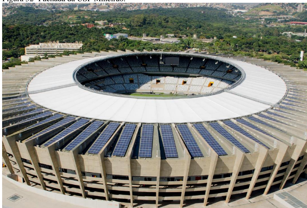
Figura 32- Fachada da USF Mineirão.
