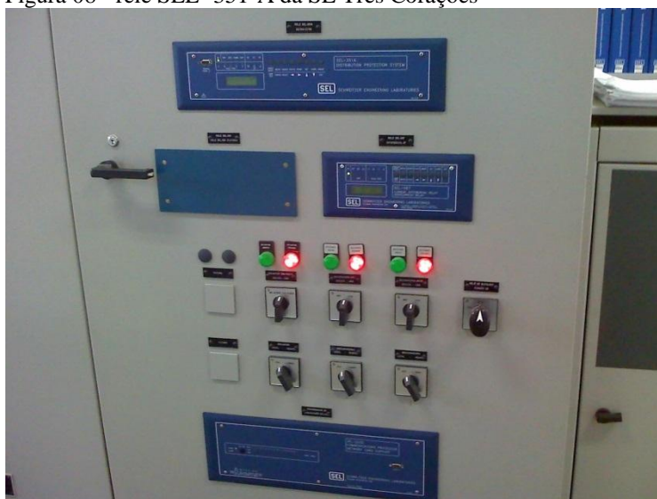
Figura 08 - relé SEL- 351-A da SE Três Corações
