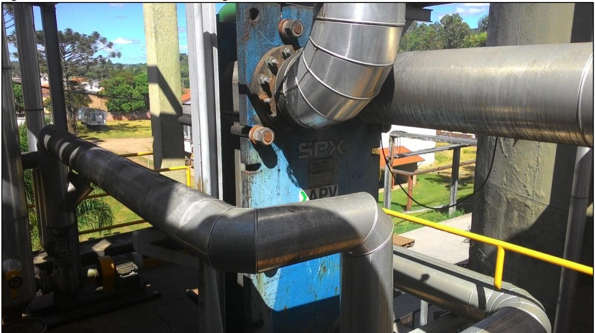
Figura 8. Trocador de calor, amônia com água
