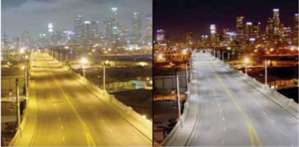
Figura 07 - Fator de uniformidade distinto para um mesmo circuito de iluminação onde foi empregado lâmpada a vapor de sódio (à esquerda) e led (à direita)
