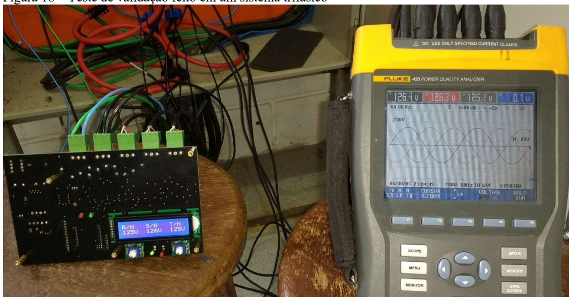
Figura 18 – Teste de validação feito em um sistema trifásico
