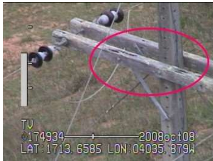
Figura 35: Cruzeta com apodrecimento na parte superior
