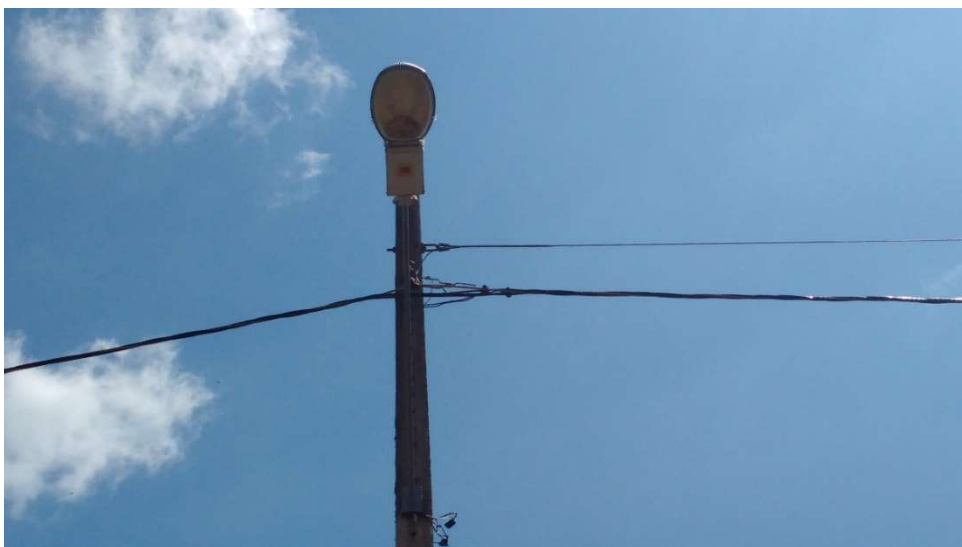
Figura 4: Rede de distribuição aérea isolada(baixa tensão)
