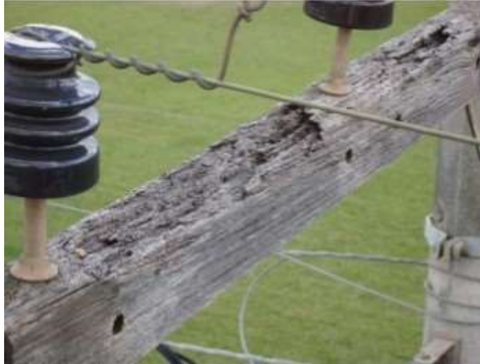
Figura 23: Perda de madeira na face superior da cruzeta
