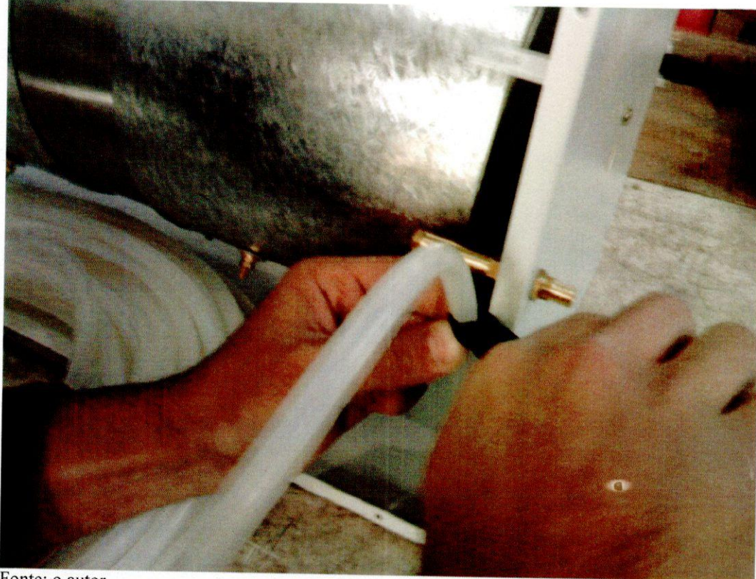
Figura 2 - Corte do tubo de silicone
