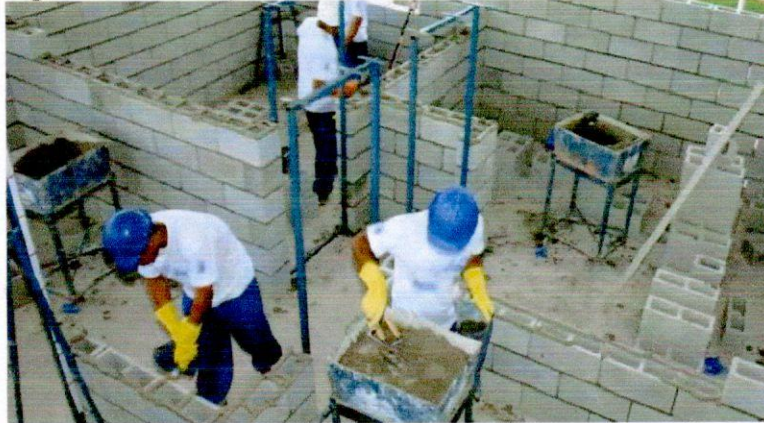
Figura 20 – instalação inadequada de execução de tubos
