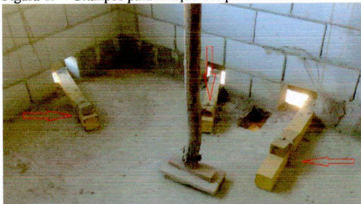
Figura 15 – Grampos para fixação dos perfis metálicos
