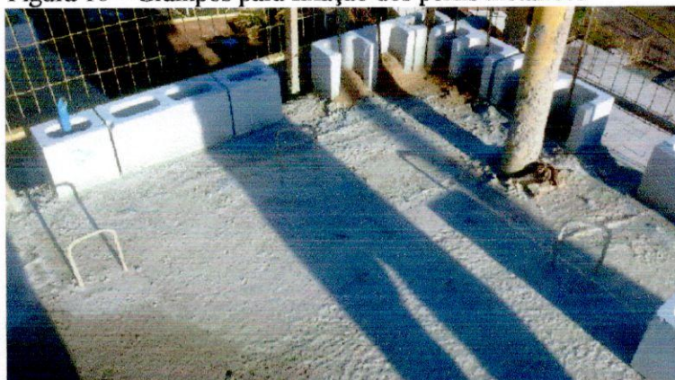
Figura 16 – Grampos para fixação dos perfis metálicos
