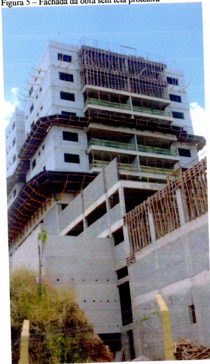
Figura 5 – Fachada da obra sem tela protetora
