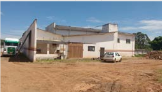
[62] Vista da edificação a partir do portão de entrada.
