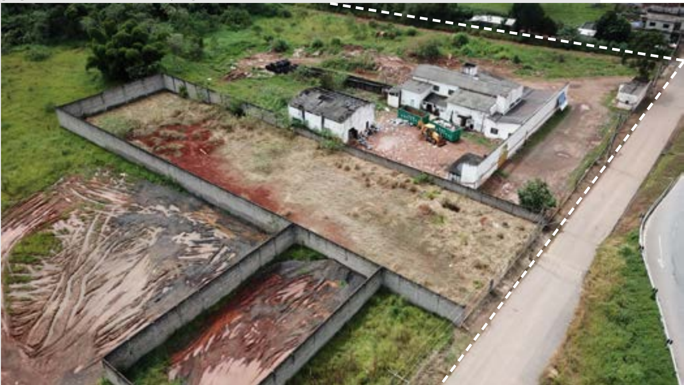
[65] Vista do terreno em sua porção construída.
