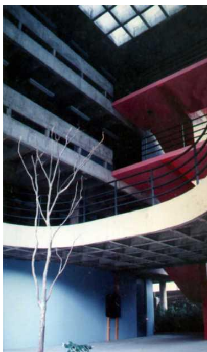
Figura 45 - Espaço central do edifício.
