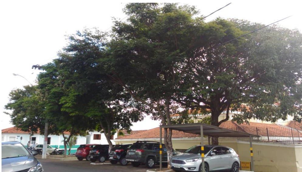
Figura 54 - Área com vegetação na fachada posterior da Igreja Matriz.
