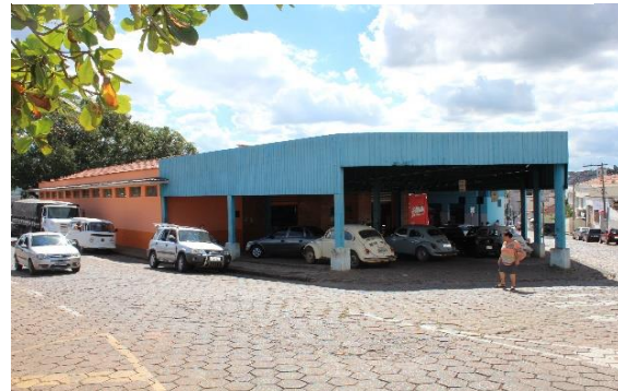
d) Fachada lateral esquerda
