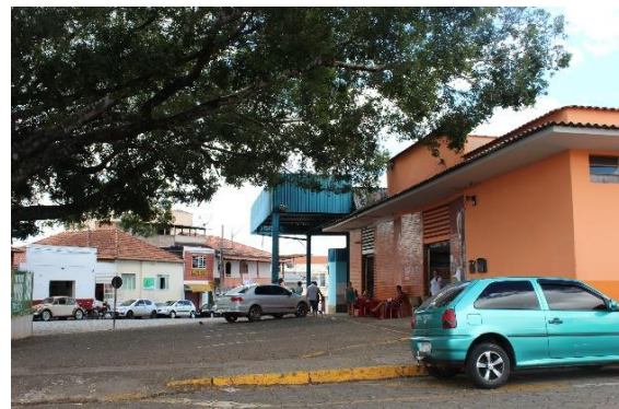
b) Fachada lateral direita
