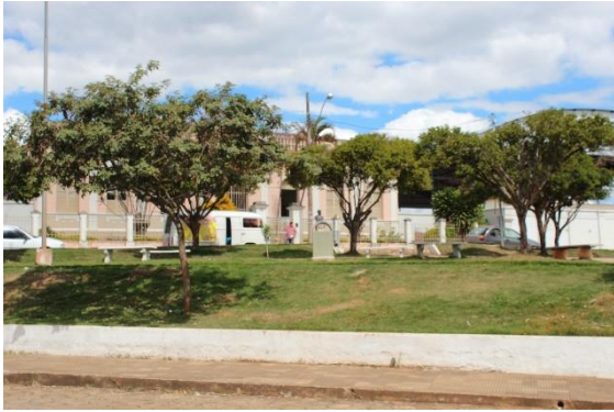
Figura 36 – Vista para fachada da escola
