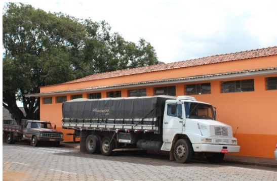
c) Fachada posterior
