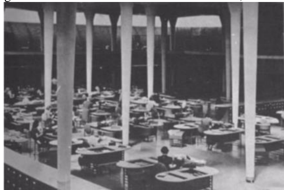
Figura 6: Frank Lloyd Wright. Edifício administrativo da S.C. Johnson, F.L. Wright, 1936.
