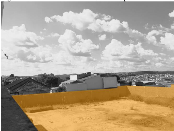
Figura 29: Foto interna do lote, lado esquerdo
