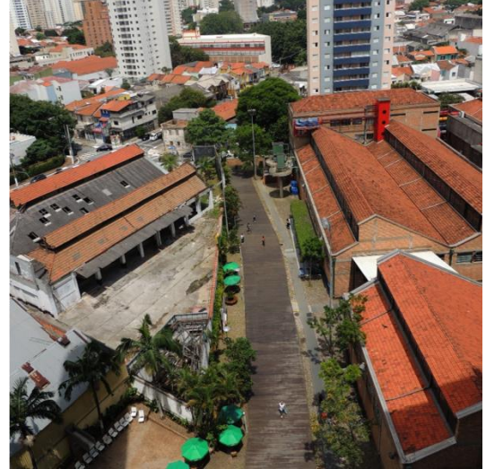
Figura 40: Rua interna, foto tirada da passarela
