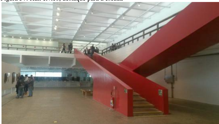
Figura 57: Hall cívico, destaque para a escada
