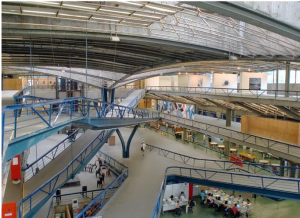
Figura 46: Rampas de acesso interno
