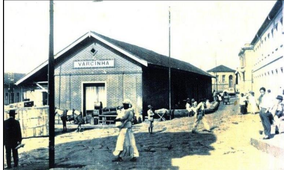
Figura 4 – Espaço insuficiente para acomodar cargas
