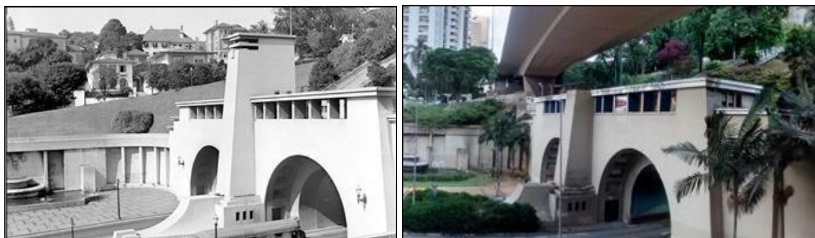
Figura 36 - Torre do Mirante demolida para construção do viaduto
