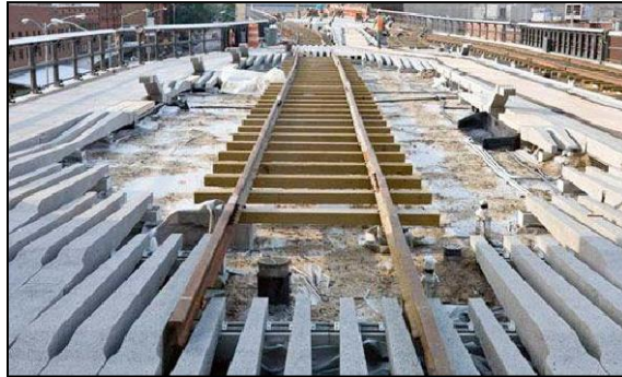
Figura 21 - Pranchas de concreto intercalados com partes do trilho original
