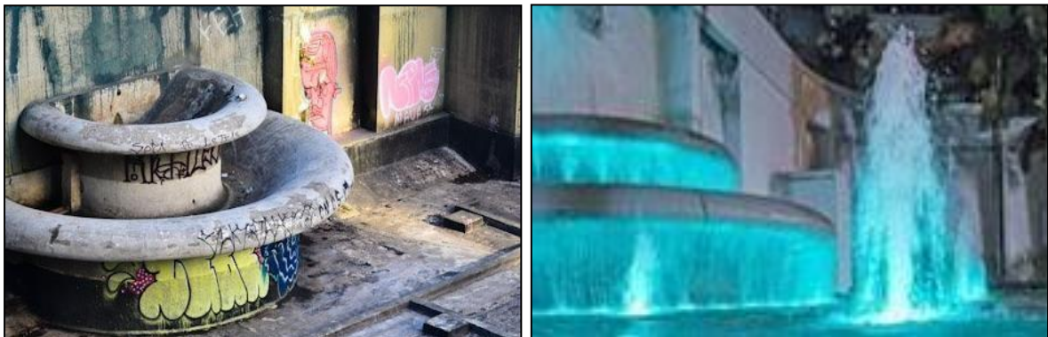
Figura 40 - Chafariz antes e após restauração
