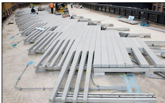
Figura 19 – Pavimentação, pranchas de concreto
