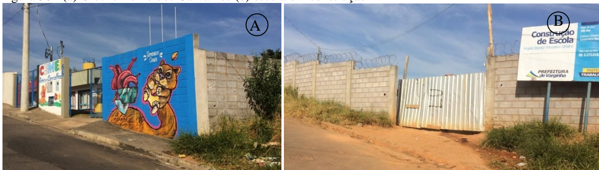
Figura 30 - (a) Creche Reino dos Carvalhos (b) escola em construção
