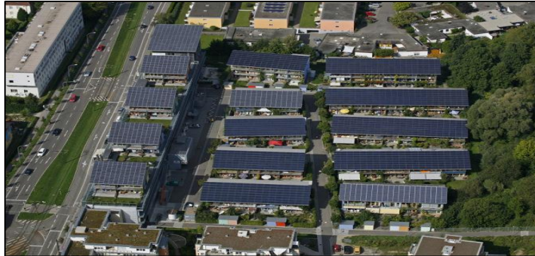
Figura 26 - Vista superior do bairro Vauban, placas das micro-usinas solares instaladas nos telhados.
