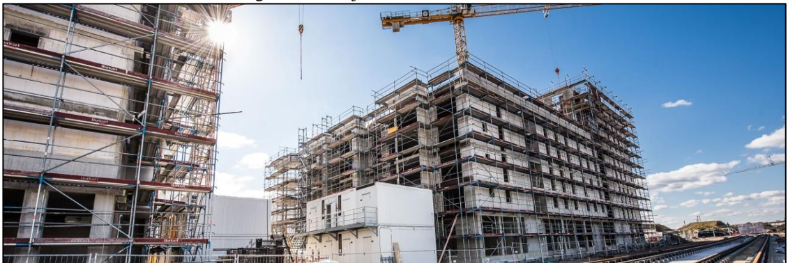
Figura 34 - Projeto sendo executado.
