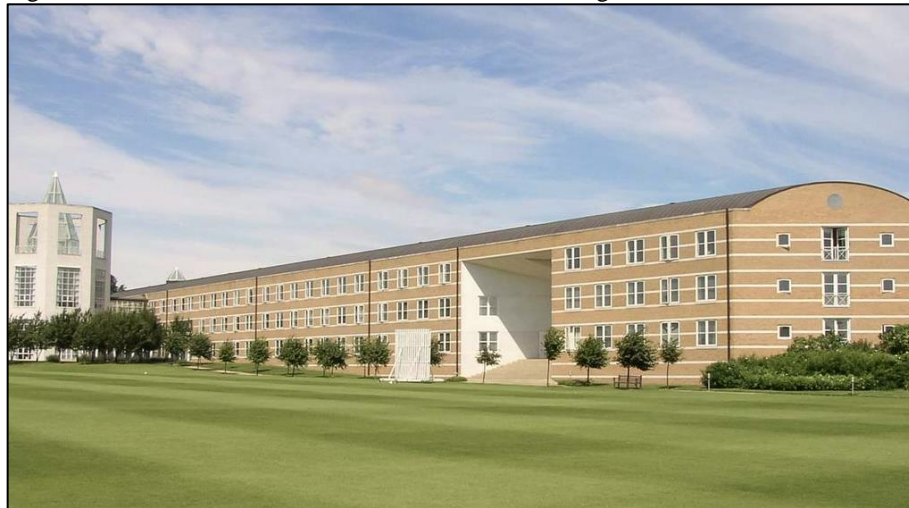
Figura 20: Vista Externa do Moller Centre em Cambridge, Reino Unido
