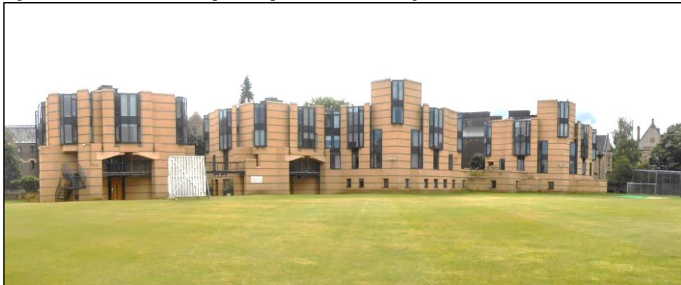
Figura 24: Vista dos blocos que compõem Balliol College, Reino Unido
