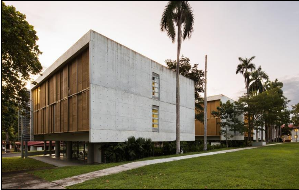
Figura 76: Vista Externa do Alojamento Estudantil na Cidade do Panamá
