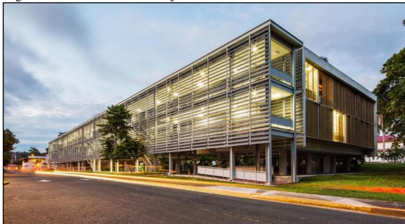
Figura 74: Vista Externa do Alojamento Estudantil na Cidade do Panamá
