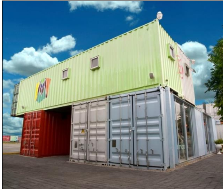
Figura 35: Vista da Container City, México
