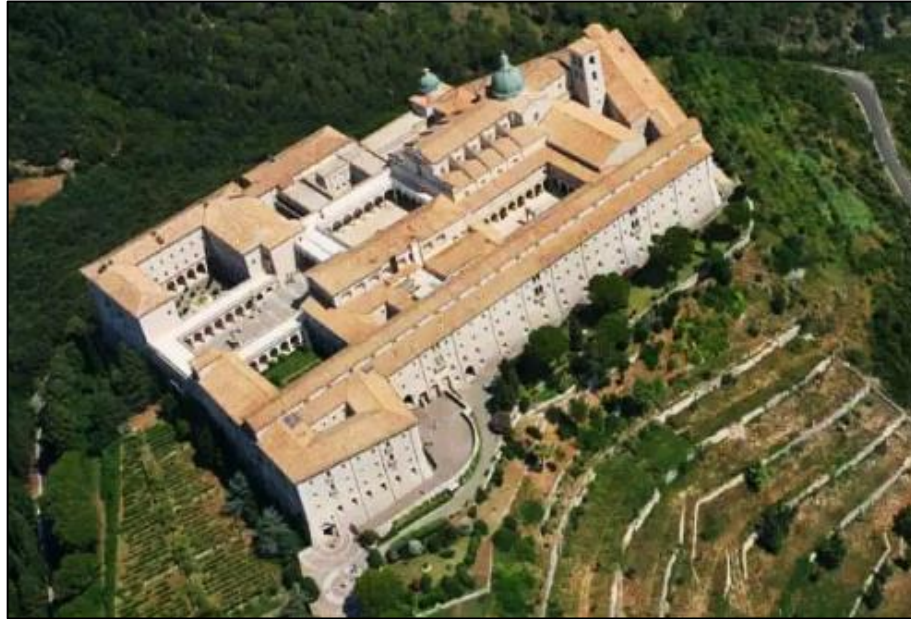
Figura 03: Vista aérea do mosteiro Monte Cassino, Itália
