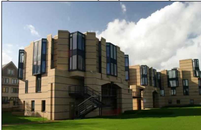
Figura 25: Vista externa dos blocos que compõem Balliol College, Reino Unido
