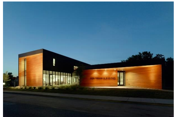
Figura 92- Cipreste e painéis metálicos na fachada sul
