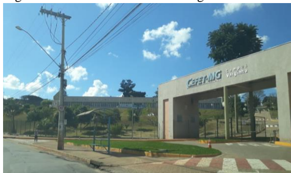
Figura 42- Fachada do CEFET-Varginha
