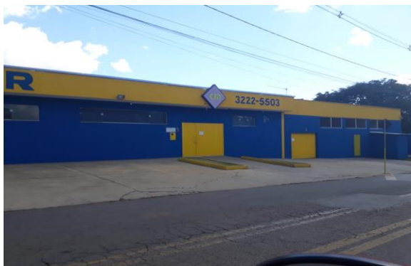
Figura 40- Fachada do Colégio Master
