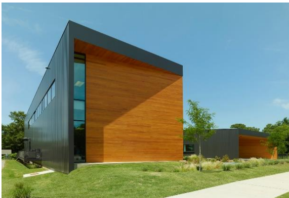
Figura 91- Cipreste e painéis metálicos na fachada sul
