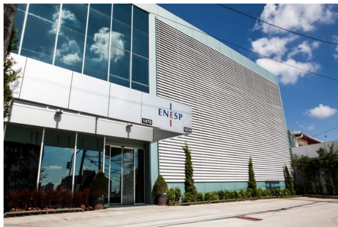
Figura 10: Fachada da Clínica ENESP.
