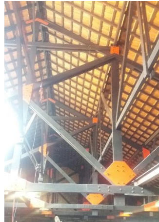
Figura 13 – SESC - Detalhe da estrutura do telhado
