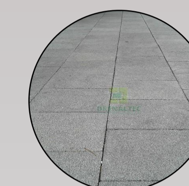
Piso Cimentício Permeável
