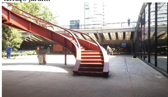
Figura 28 – CCSP – Escada externa de acesso ao terraço jardim
