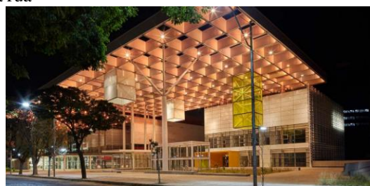
Figura 56 Estação da Cultura Franco – Fachada frontal, Pres. Itamar Franco – Praça de alimentação aberta para a rua
