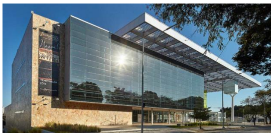
Figura 55 – Estação da Cultura Pres. Itamar com destaque para a transparência do edifício
