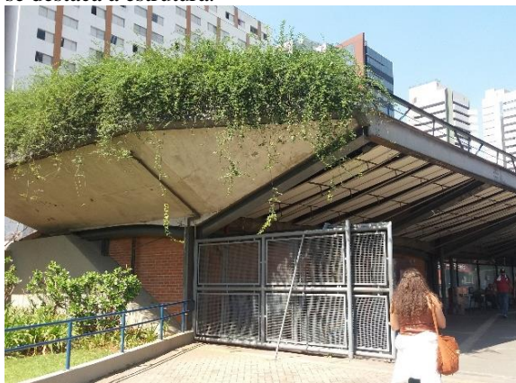
Figura 24 – CCSP – Entrada principal, em que se destaca a estrutura.
