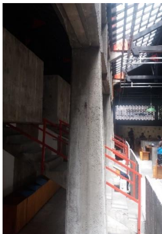
Figura 12 – SESC - Detalhe Estrutura de concreto
