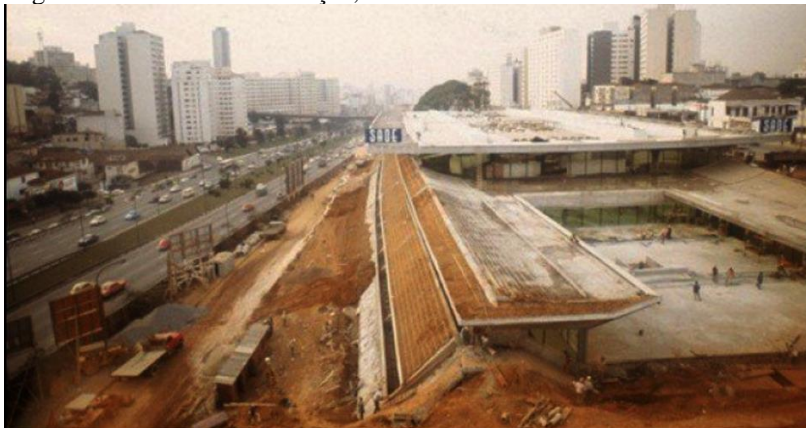
Figura 23 – CCSP – Construção, em 1979.
