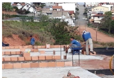
Figura 2: Assentamento de tijolo cerâmico furado
