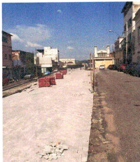
Figura 18 – Praça da Estação em reforma Fonte: a autora
