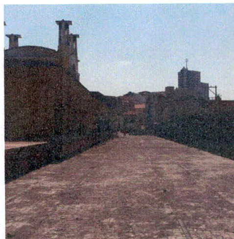
Figura 19 – Praça da Estação em reforma Fonte: a autora
