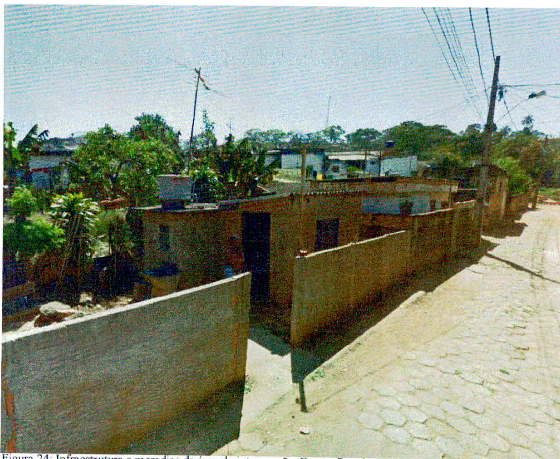
Figura 24: Infraestrutura e moradias da área de intervenção. Fonte: Google 2013.
