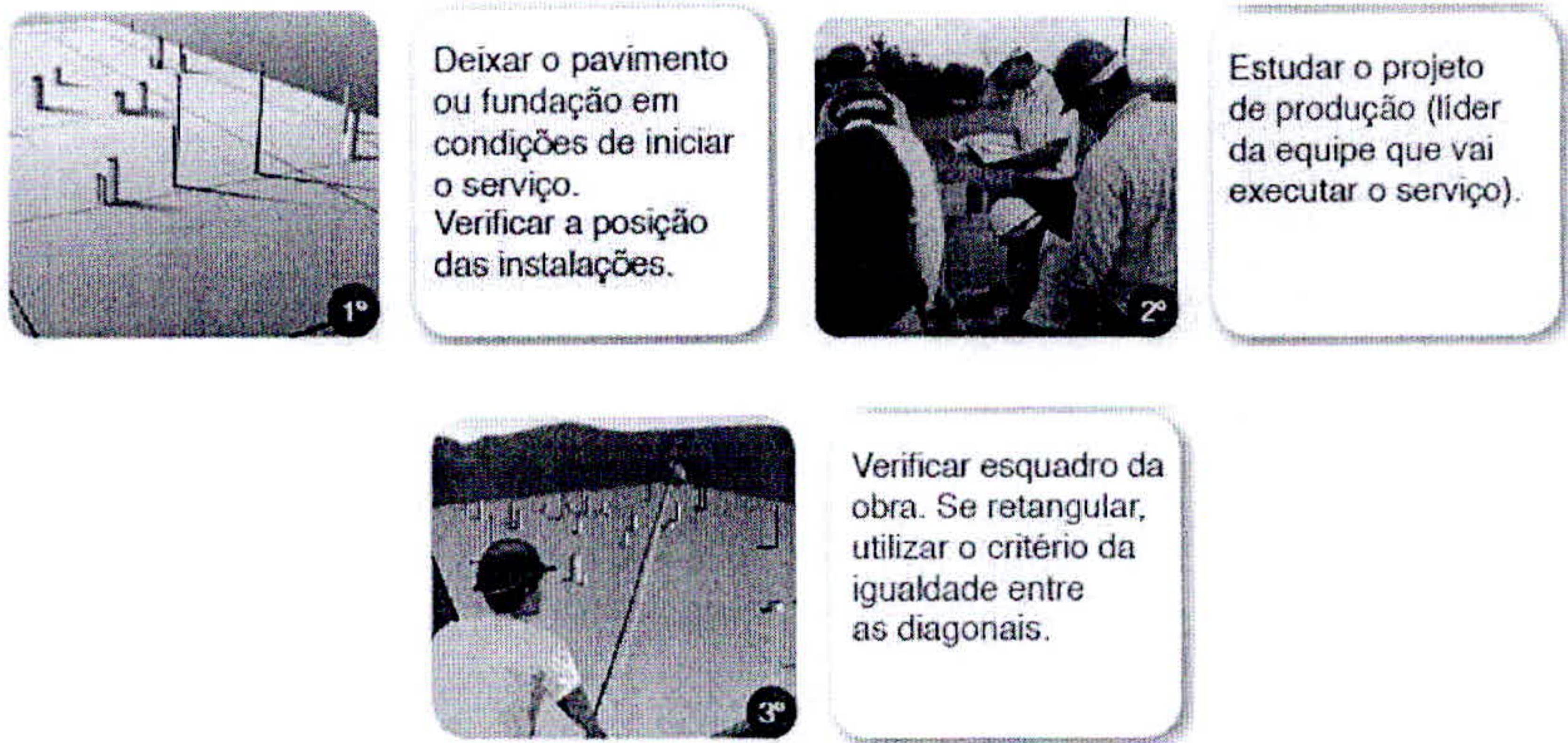
Figura 30 - Verificar instalações, estudar o projeto e verificar o esquadro
