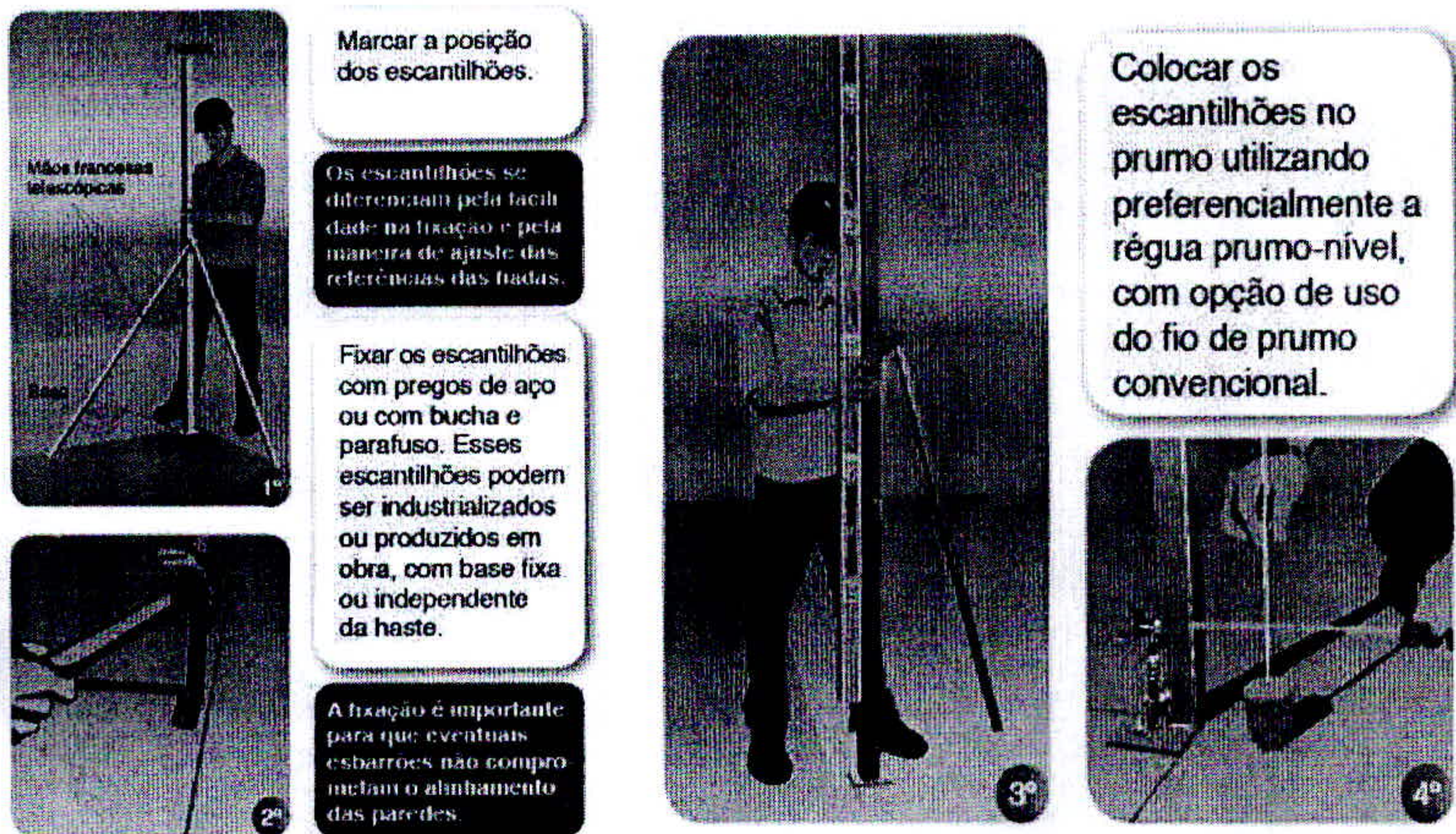
Figura 32- Instalação dos escantilhões
