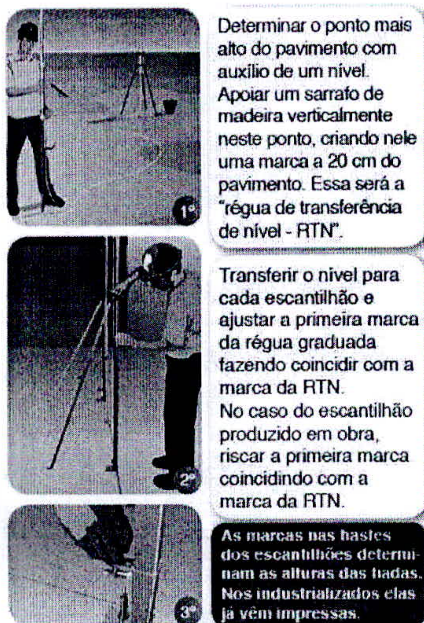
Figura 33- Nivelamento das fiadas
