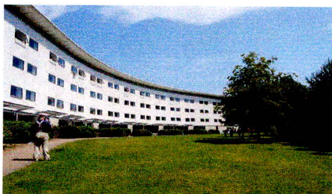
Figura 14 - Foto externa da moradia estudantil Alliance Student Housing, em Newington Green, Londres. Arquitetos: Escritório Haworth Tompkins Architects.
