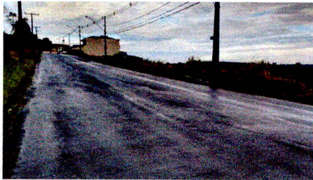
Figura 20 – Vista da área de Intervenção escolhida, Rua Agenor Agnaldo Braga, localizada no bairro Vila Adelaide, Varginha - MG.
