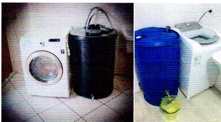
Figura 5: Reaproveitamento da água da máquina de lavar roupas.
