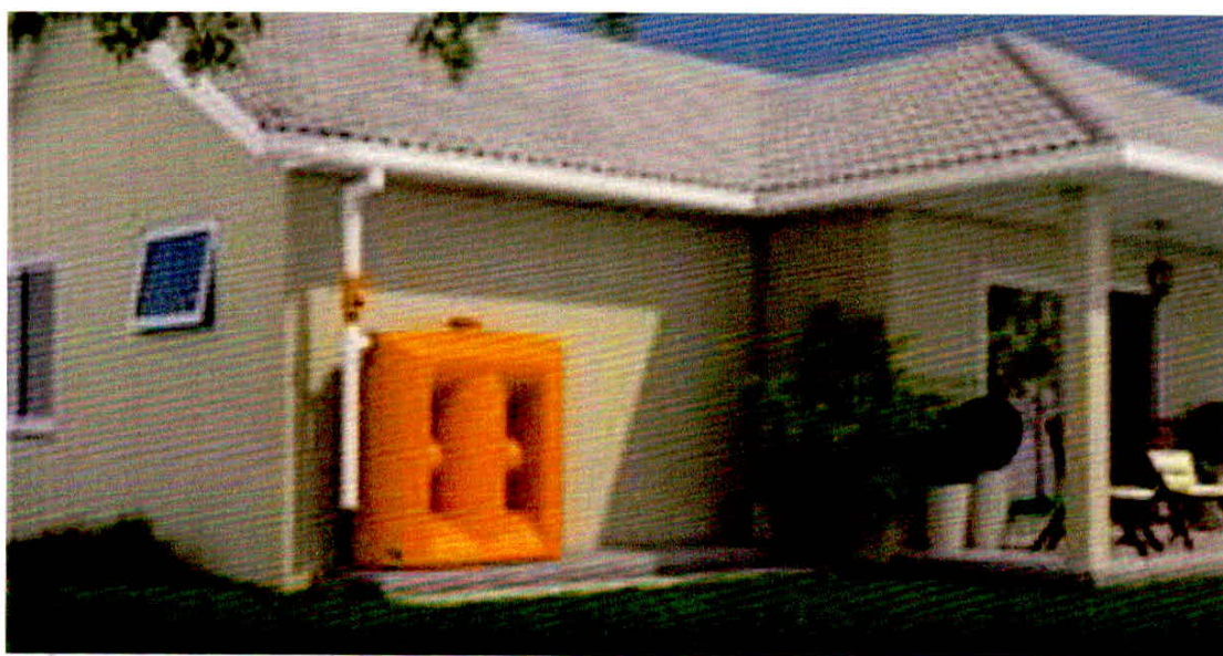
Figura 50: Recuperação águas pluviais Fonte: Recuperado de< https://www.youtube.com/watch?v=QVYvR6Q3tLo >. Acesso em 15 mai. 2016.
