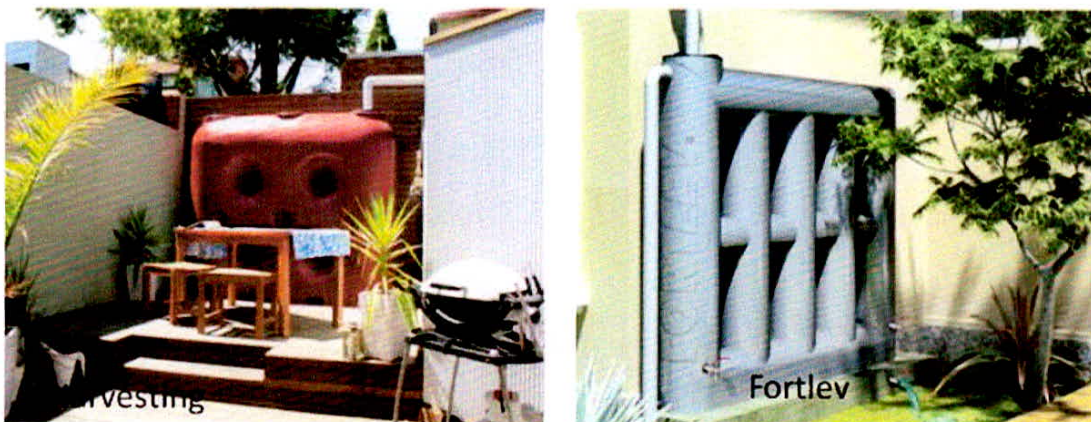
Figura 51: Reservatórios água de chuva
