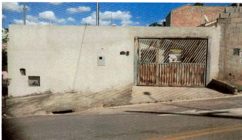
Figura 43: Muro frontal da residência em estudo Fonte: Arquivo pessoal (2015)
