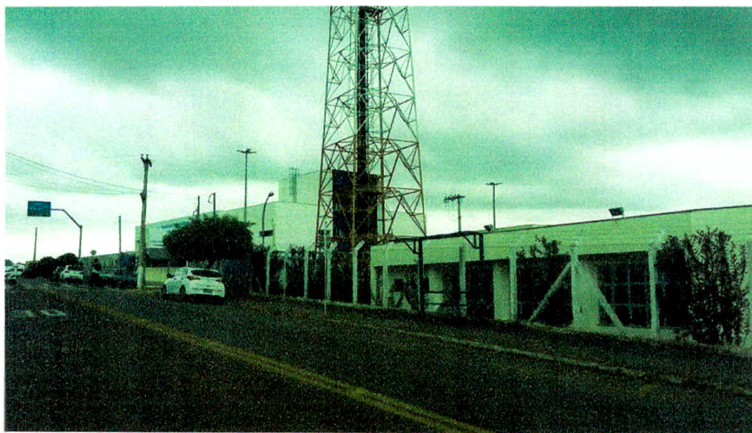
Figura 39- Ponto de ônibus Fonte: A autora Acesso em : 25/11/2015
