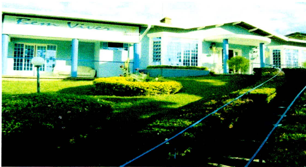
Figura 28 – Fachada Fonte: http://www.repousobemviver.com.br/ Acesso em: 23/09/2015
