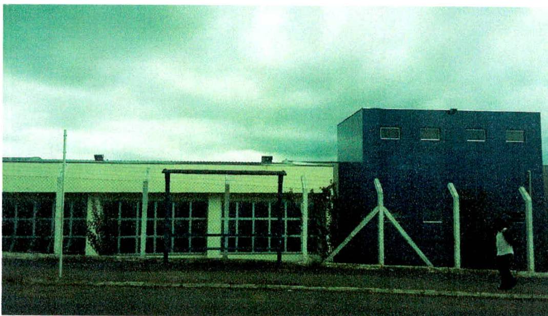
Figura 40 – Ponto de ônibus Fonte: A autora Acesso em : 25/11/2015
