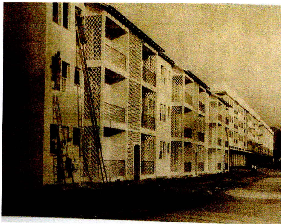
Figura 8 – Bloco 3 com três pavimentos e varandas, fechadas lateralmente por cobogós Fonte: Bonduki (2014)
