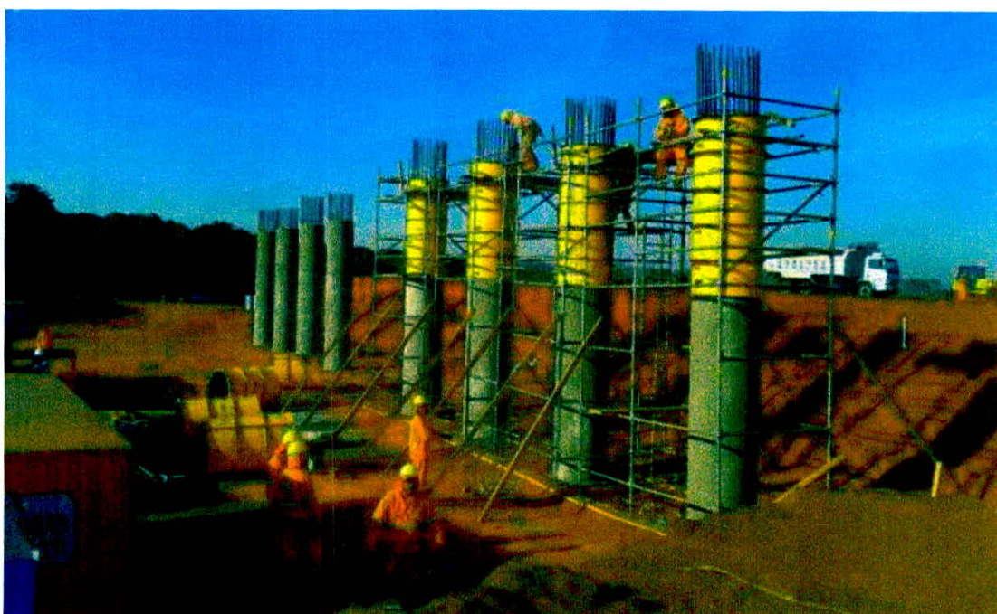
Figura 24: Pilares de concreto armado
