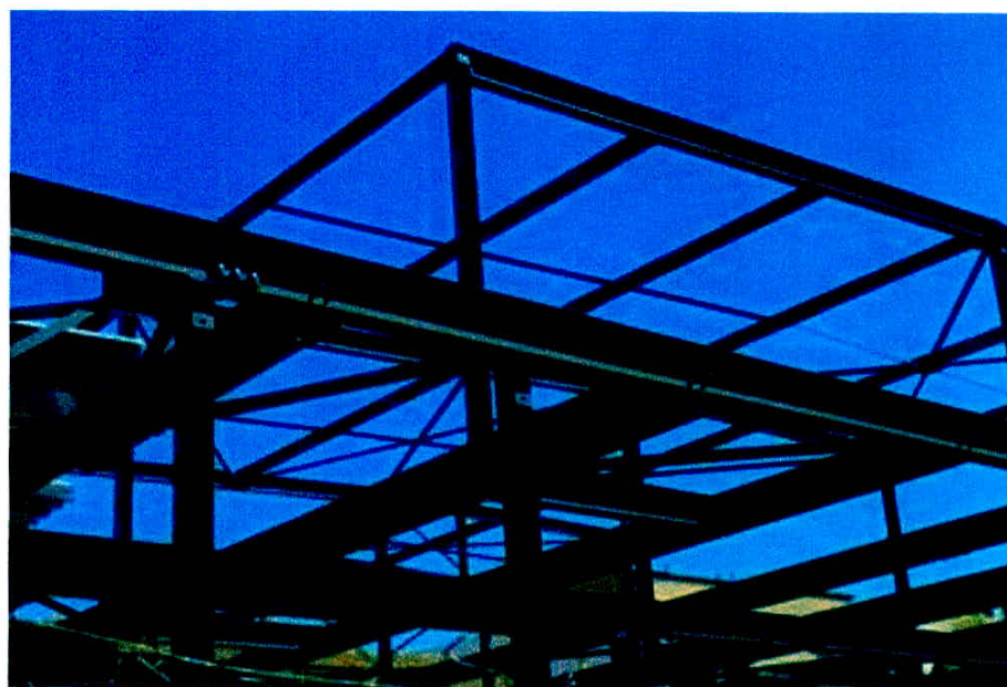
Figura 25: Sistema de estrutura metálica
