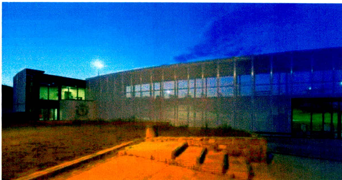
Figura 30: Fachada com Membrana
