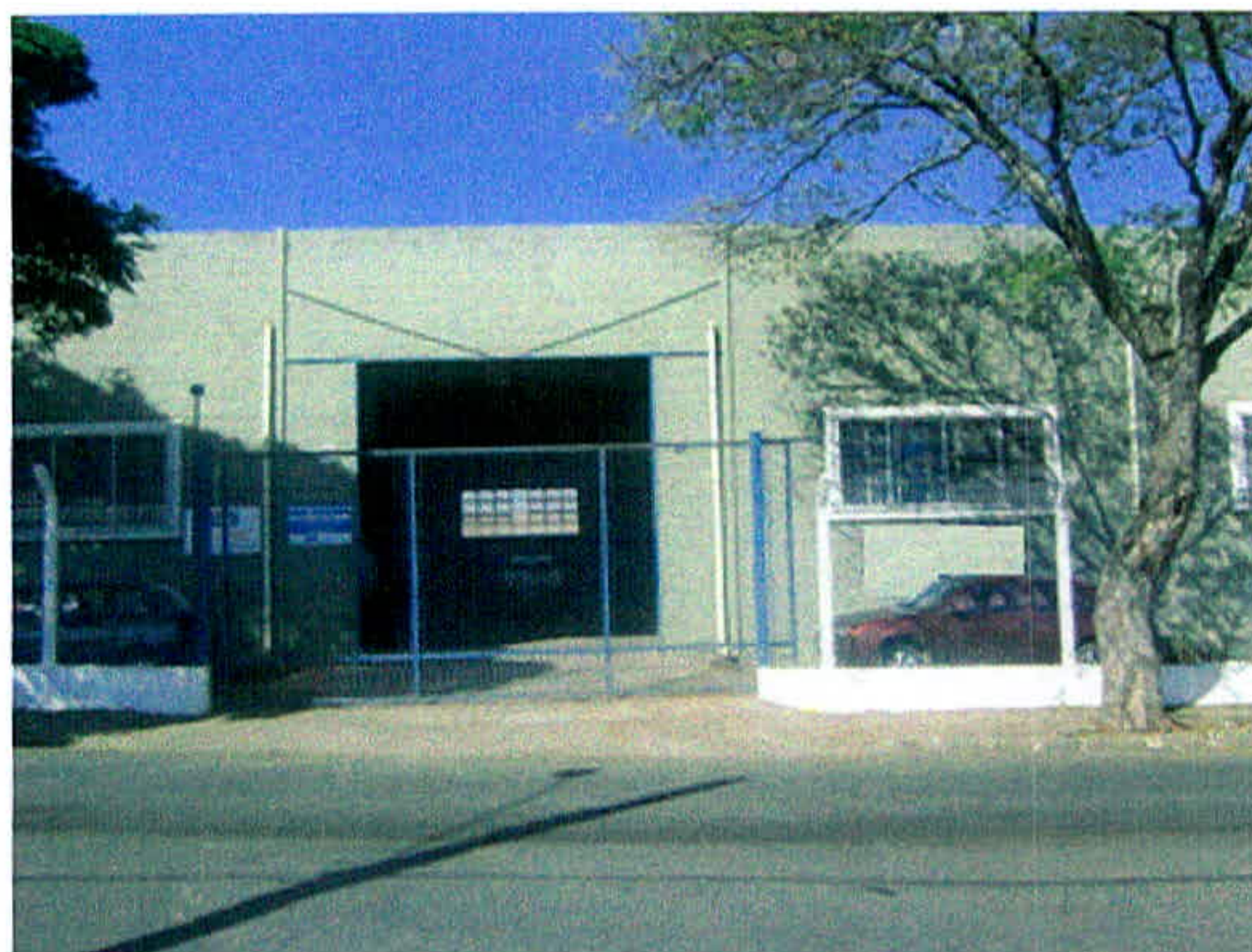
Foto 02: Face frontal do galpão, detalhe portão e vitrô
