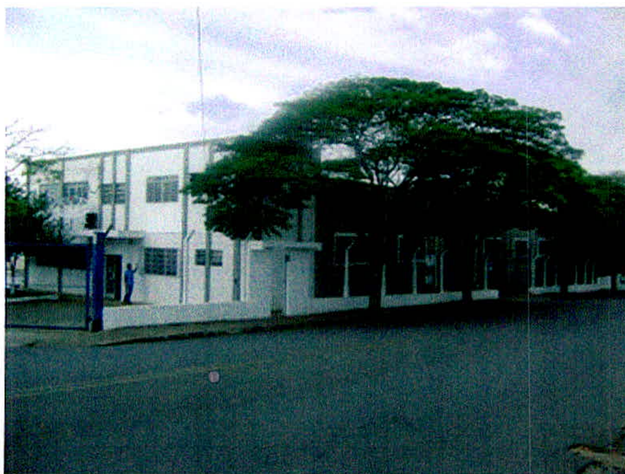
Foto 01: Galpão industrial, vista panorâmica
