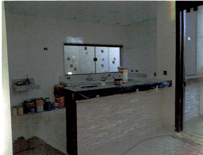
Foto 10. Fase de Acabamento. Balcão em filetes de pedra. Data: Maio/2013
