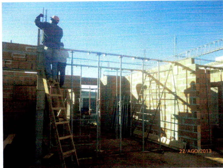
Foto 02. Montagem de Vigas Pavimento Térreo. Data: Agosto/2013
