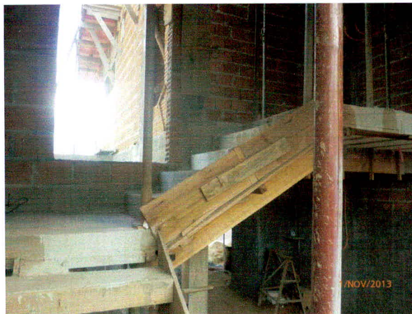
Foto 05. Escada Concretada. Data: Novembro/2013
