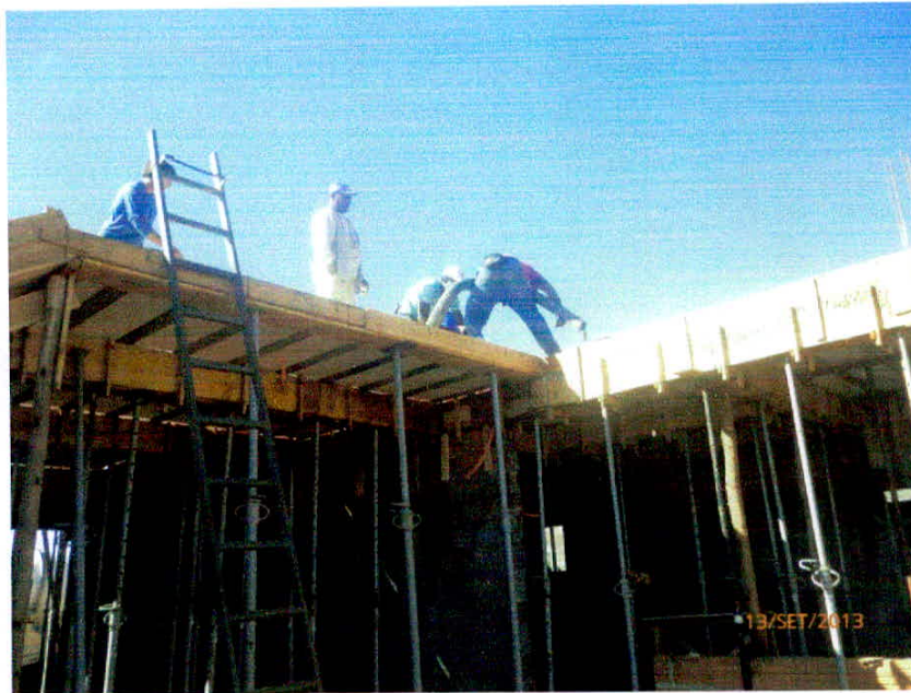
Foto 04. Concretagem da Laje Pavimento Térreo. Data: Setembro/2013
