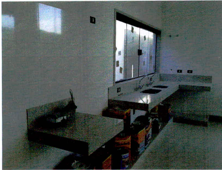
Foto 12. Fase de Acabamento.Revestimento Cozinha. Data: Maio/2013
