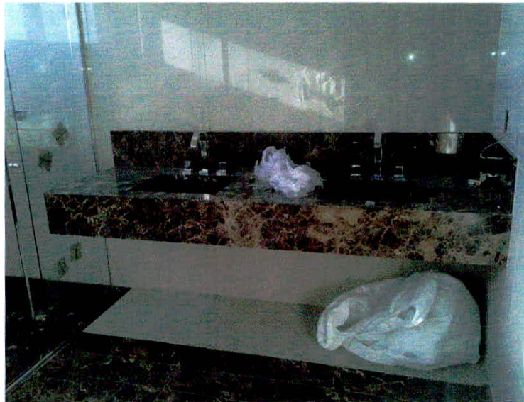
Foto 13. Fase de Acabamento.Revestimentos Banheiro da Suíte. Data: Maio/2013
