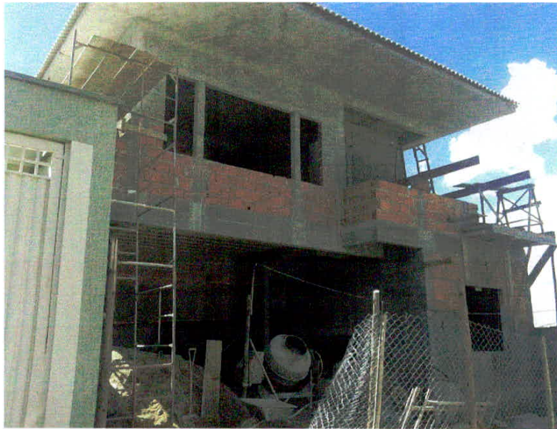
Foto 08. Reboco Externo da Laje. Data: Dezembro/2013
