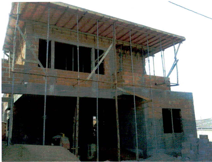
Foto 06. Escoras da Laje do Pavimento Superior. Data: Novembro/2013
