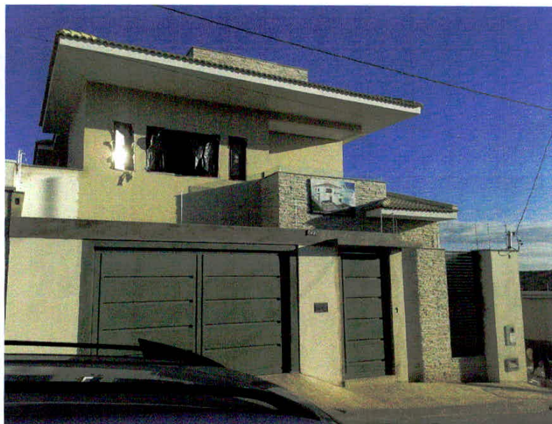
Foto 09. Fase de Acabamento. Pintura Externa. Data: Maio/2013
