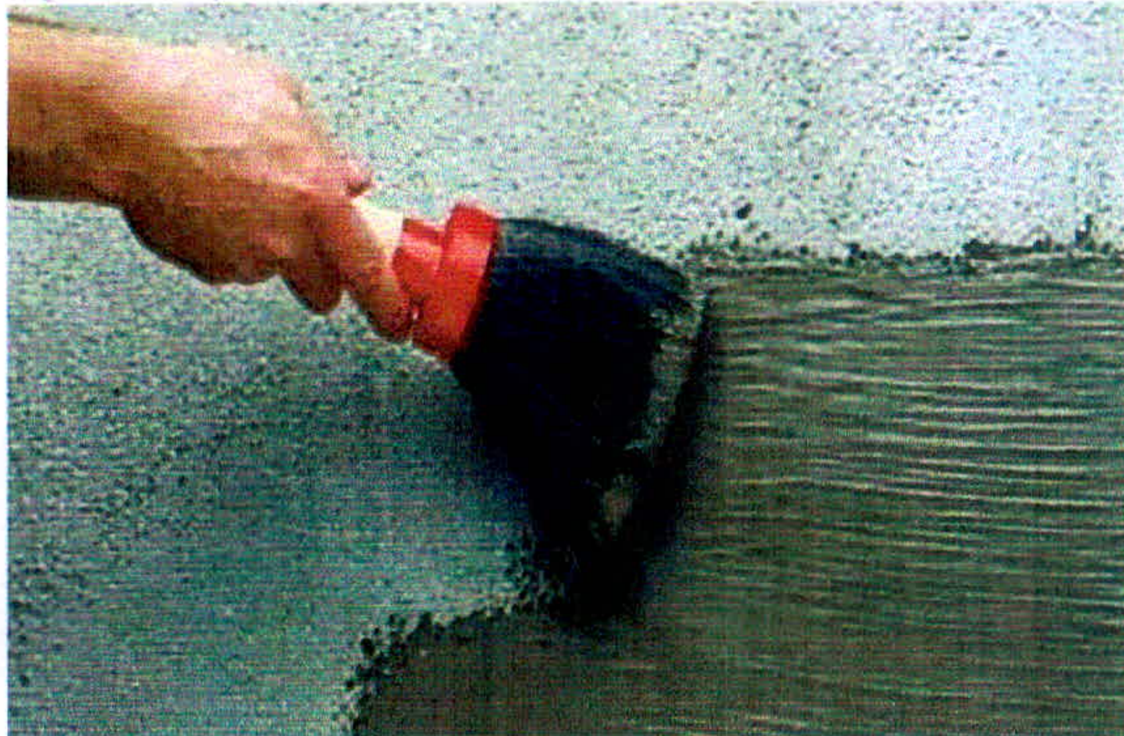
Figura 13 – Aplicação de argamassa polimérica na forma de pintura.
