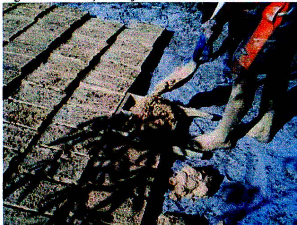
Figura 3 – Fabricação do tijolo adobe
