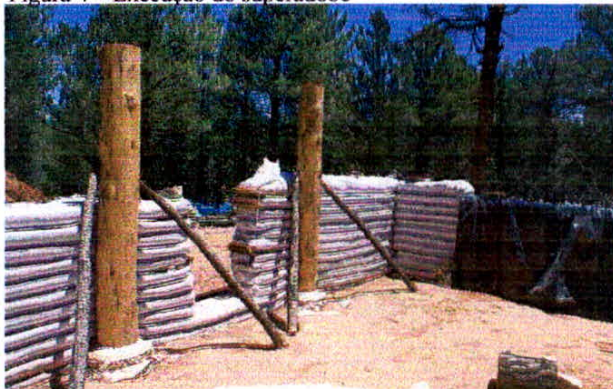
Figura 4 – Execução do superadobe
