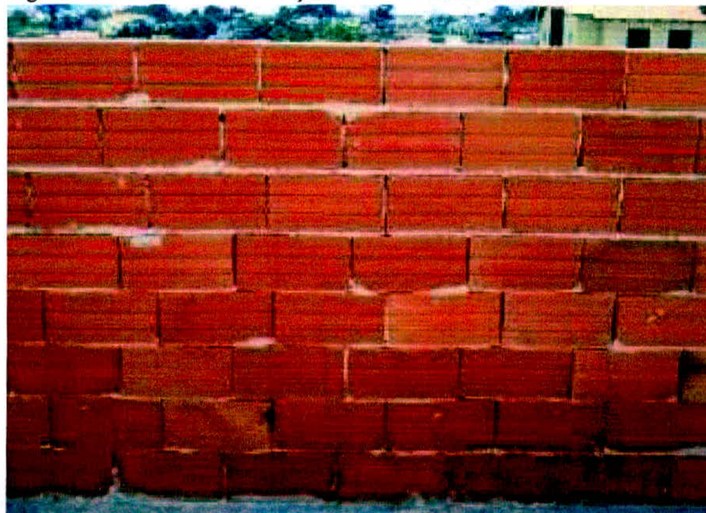
Figura 08 – Alvenaria com utilização de blocos cerâmicos furados
