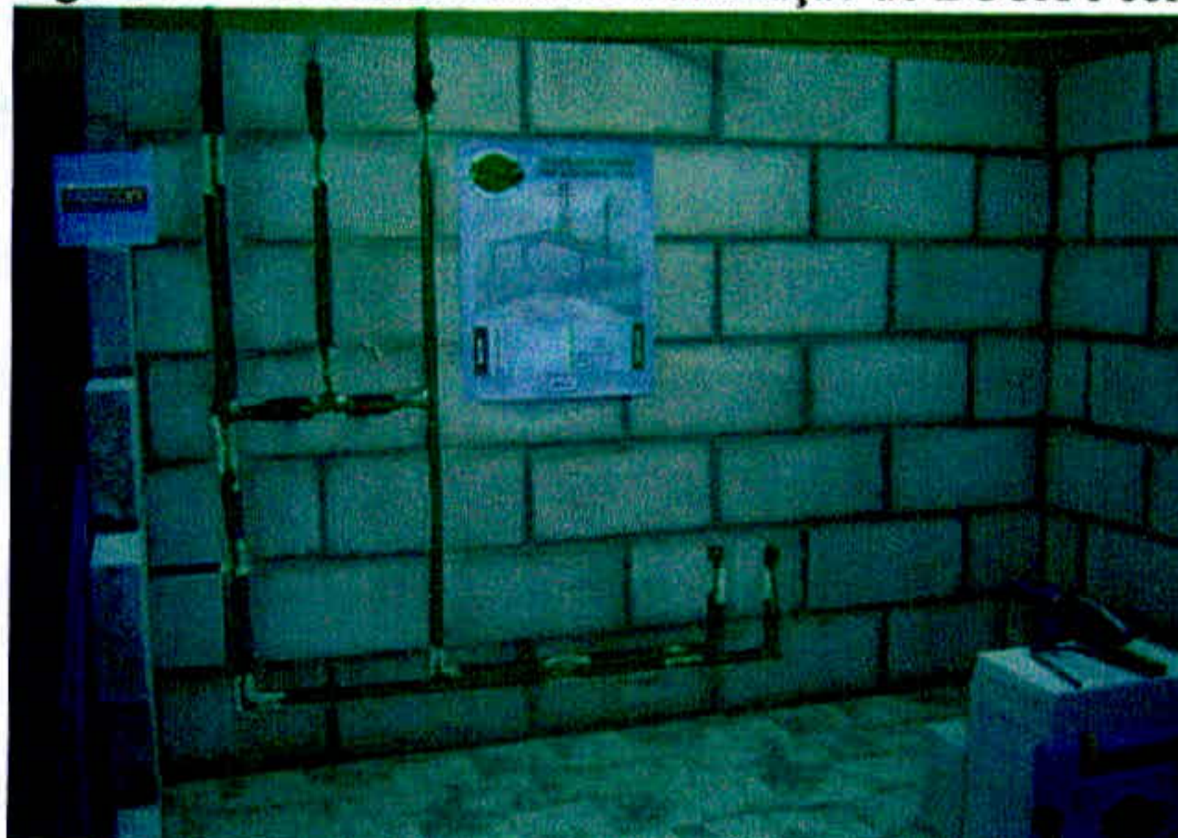
Figura 06 – Alvenaria feita com utilização do BCCA e com tubulação instalada
