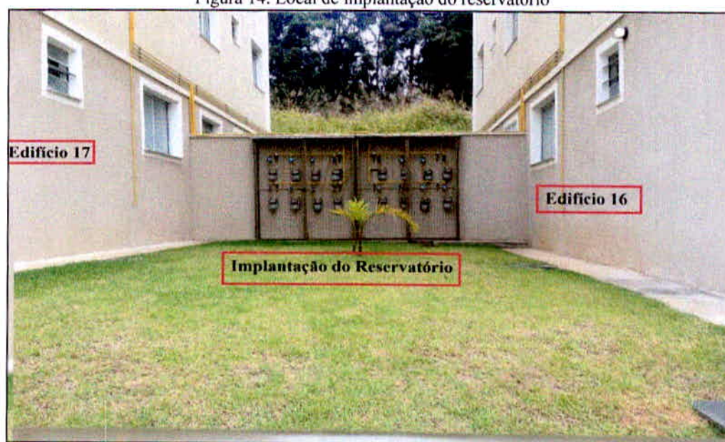
Figura 14. Local de implantação do reservatório
