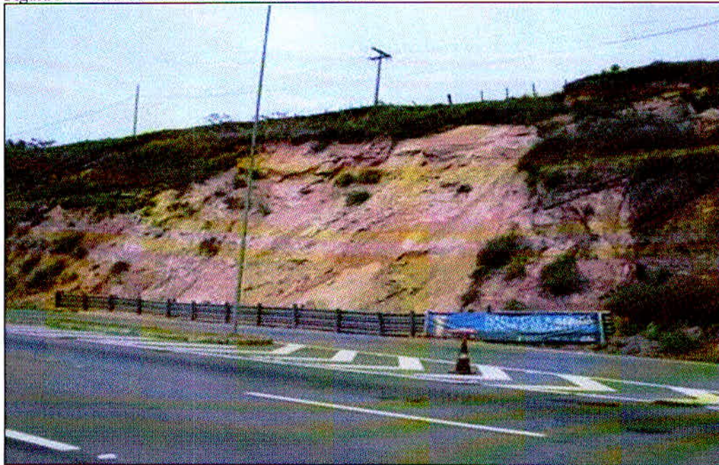
Figura 24 - Vista frontal e lateral do talude em 2009.
