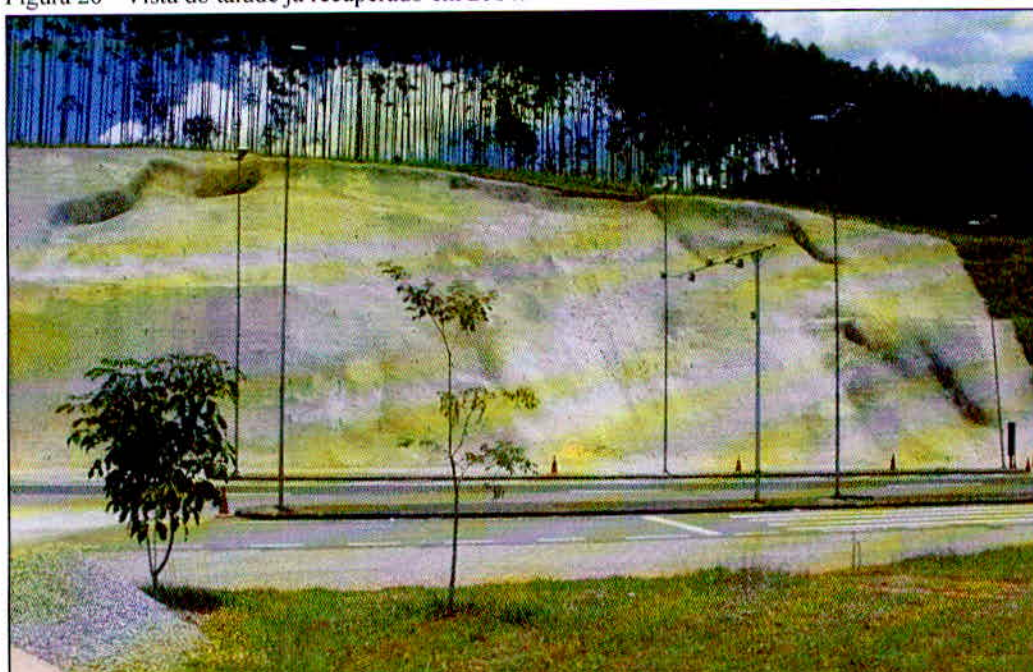
Figura 26 - Vista do talude já recuperado em 2014.
