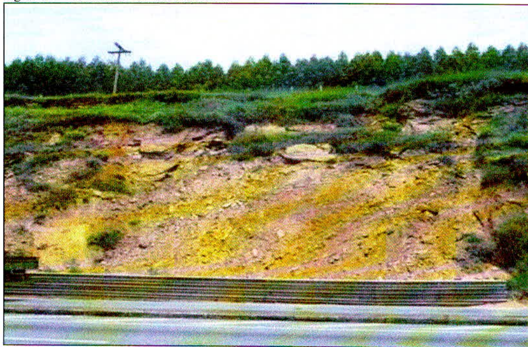
Figura 25 - Vista frontal do talude em 2011.
