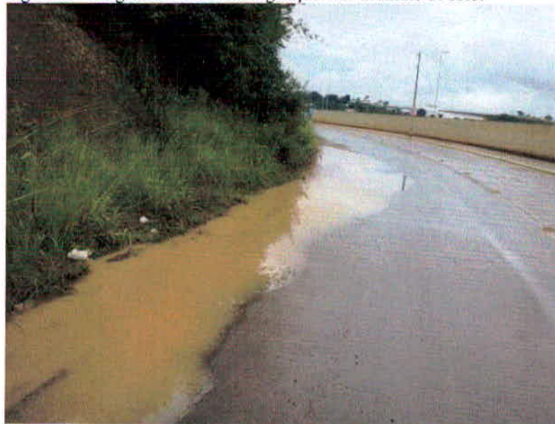
Figura 11– Alagamento devido a vegetação e ao acúmulo de solo.
